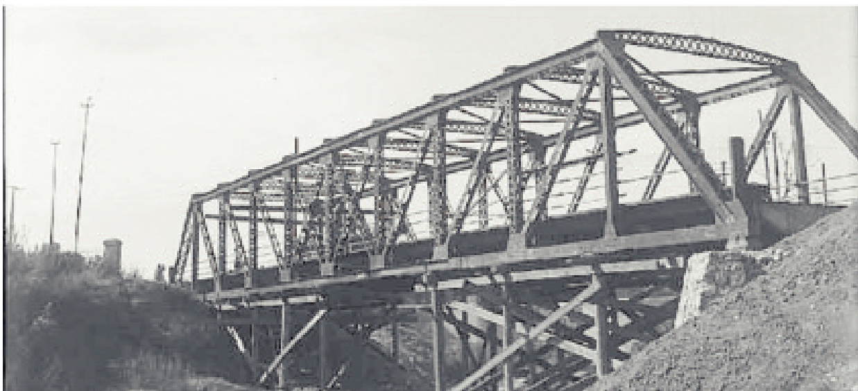
El “Puente Blanco” antes de su demolición, por debajo circulaba el “San Martín” ferrocarril que en la época unía Mendoza y Retiro. (Foto José Lavía)
